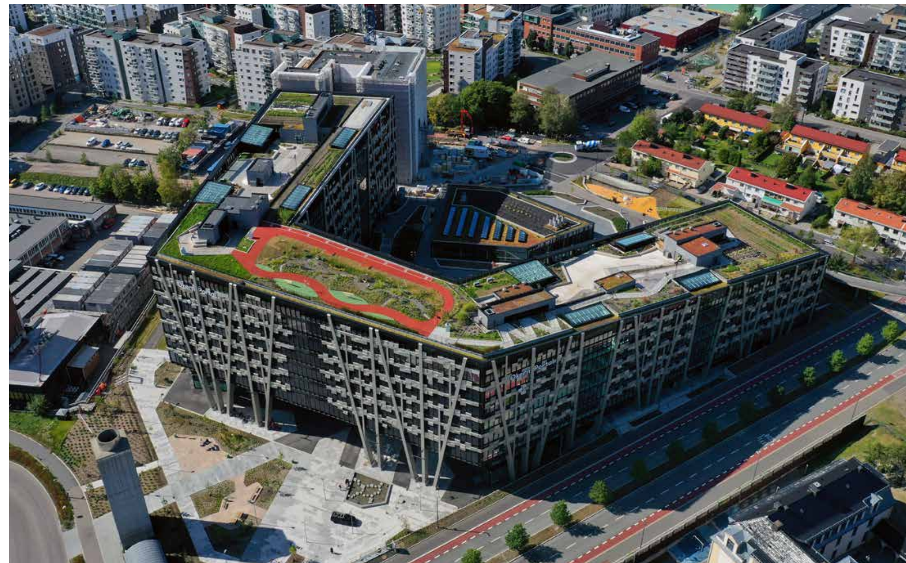
Økern Portal er et av Norges største og mest miljøvennlige kontorbygg, med egen takpark på 7 000 kvm. Dimensjonene gjør blant annet at taket tar unna betydelige mengder overvann når det er kraftig regnvær. | Foto: Stema Rådgivning
