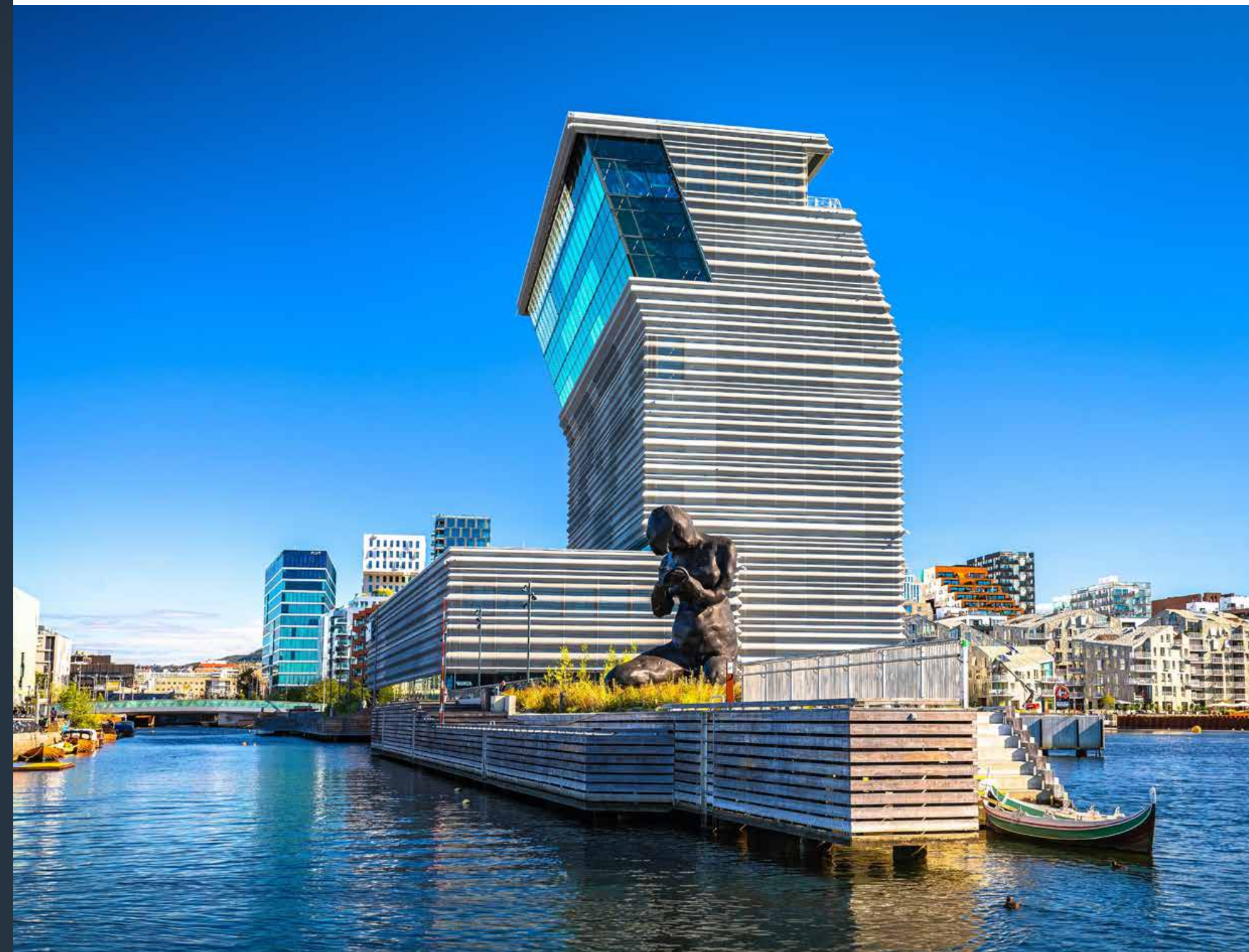
Munchmuseet er et av mange signalbygg i Oslo som Oslo Forsikring forsikrer. | Foto: Shutterstock
